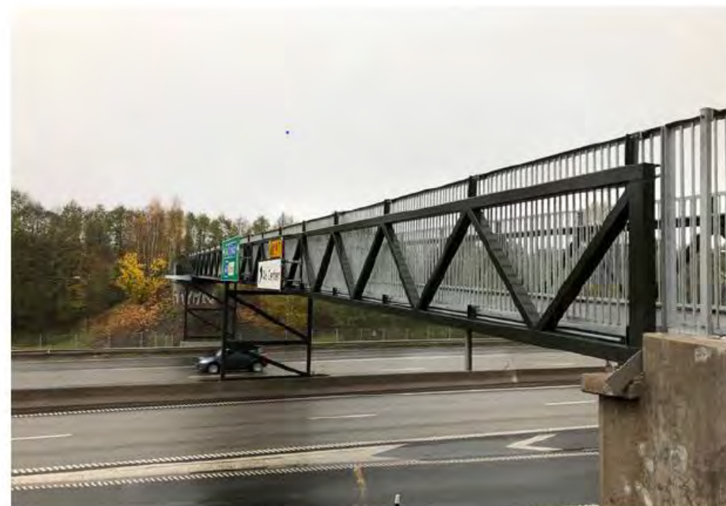
Bild 2. Nyrenoverad suicidskyddad bro. Räcket har gjorts högre och icke-klättringsbart. Källa: Jönköpings kommun.
