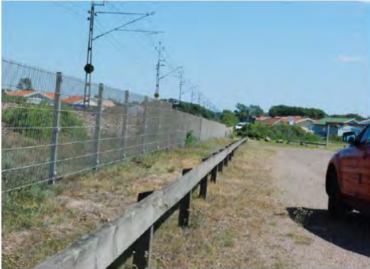
Bild 24. Stängsel längs järnvägen. Källa: Varbergs kommun.
